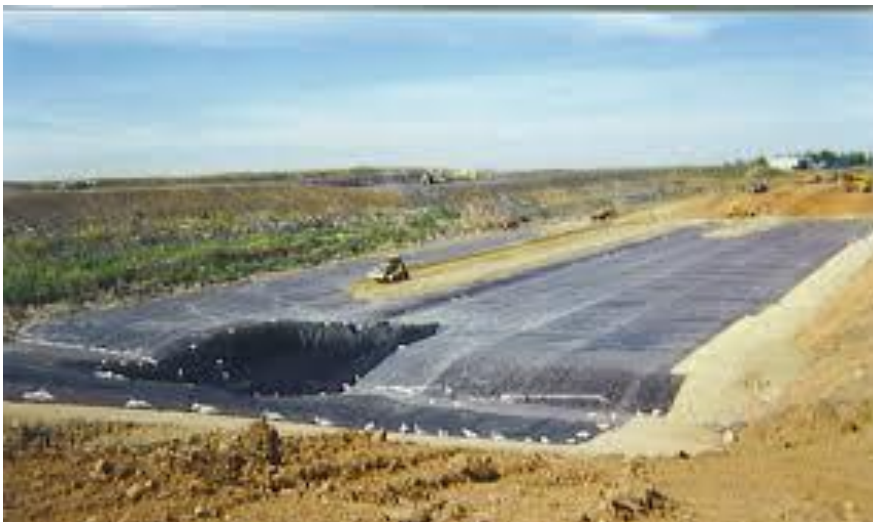
Gambar 3. Model Metode area, merupakan TPA dengan tanah datar (Damanhuri, 1995).
